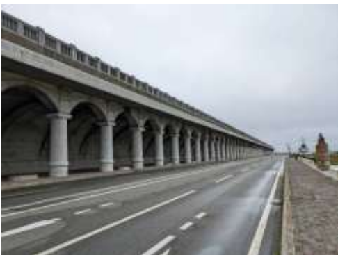
稚内港北防波堤ドーム
