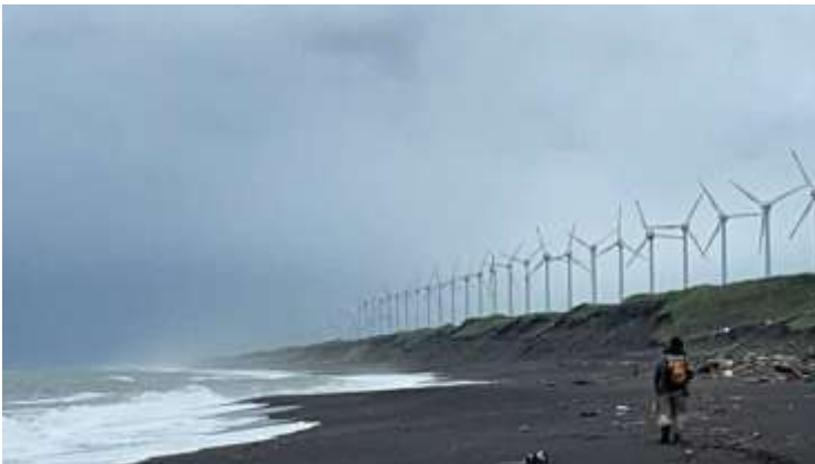
風力発電設備が立ち並ぶ海岸線
