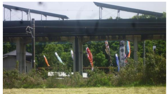
宮崎リニア実験線遺構／太陽光発電所
